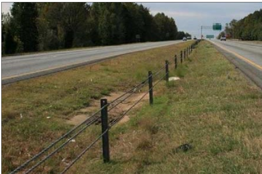
Bild 1. Mitträcke av vajertyp i USA.
