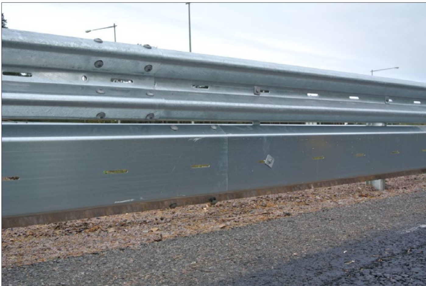
Bild 3. W-profilräcke försett med MPS, nymontage 2014 på importerat räcke. Plats E4 utanför Gävle.
