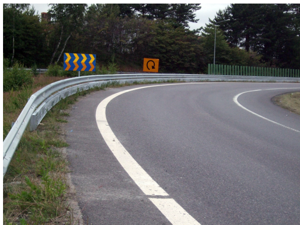
Samma motorvägsavfart med nytt räcke och underglidningsskydd monterat.
