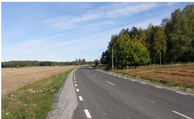
Färdig väg efter infräsning och ny beläggning. Foto: T. Viklund
